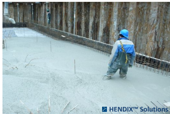
Несущий фундамент для 8-этажного жилого дома на ул. Кройцвальди в г. Таллин/Эстония (несущая фундаментная плита 2 000 м 2 , Hendix Prime 75/52 – 60 кг/м 3 , толщина фундамента 700 мм)
