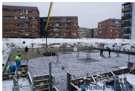
Несущий фундамент для 6-этажного жилого дома №4, на улице Идапуллу в г. Таллин/Эстония (несущая фундаментная плита 600 м 2 , Hendix Prime 75/52 – 60 кг/м 3 , толщина фундамента 600 мм)
