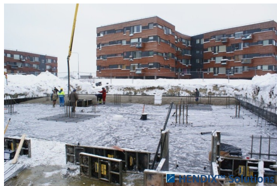
Несущий фундамент для 6-этажного жилого дома №4, на улице Идапуллу в г. Таллин/Эстония (несущая фундаментная плита 600 м 2 , Hendix Prime 75/52 – 60 кг/м 3 , толщина фундамента 600 мм)
