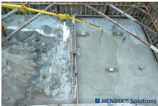
Несущий фундамент для 8-этажного жилого дома на ул. Кройцвальди в г. Таллин/Эстония (несущая фундаментная плита 2 000 м 2 , Hendix Prime 75/52 – 60 кг/м 3 , толщина фундамента 700 мм)
