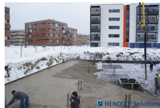
Несущий фундамент для 6-этажного жилого дома №4, на улице Идапуллу в г. Таллин/Эстония (несущая фундаментная плита 600 м 2 , Hendix Prime 75/52 – 60 кг/м 3 , толщина фундамента 600 мм)
