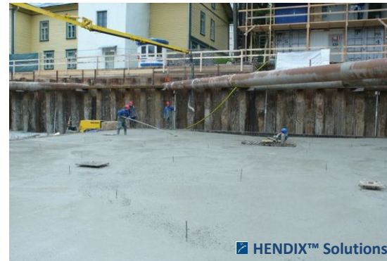
Несущий фундамент для 8-этажного жилого дома на ул. Кройцвальди в г. Таллин/Эстония (несущая фундаментная плита 2 000 м 2 , Hendix Prime 75/52 – 60 кг/м 3 , толщина фундамента 700 мм)
